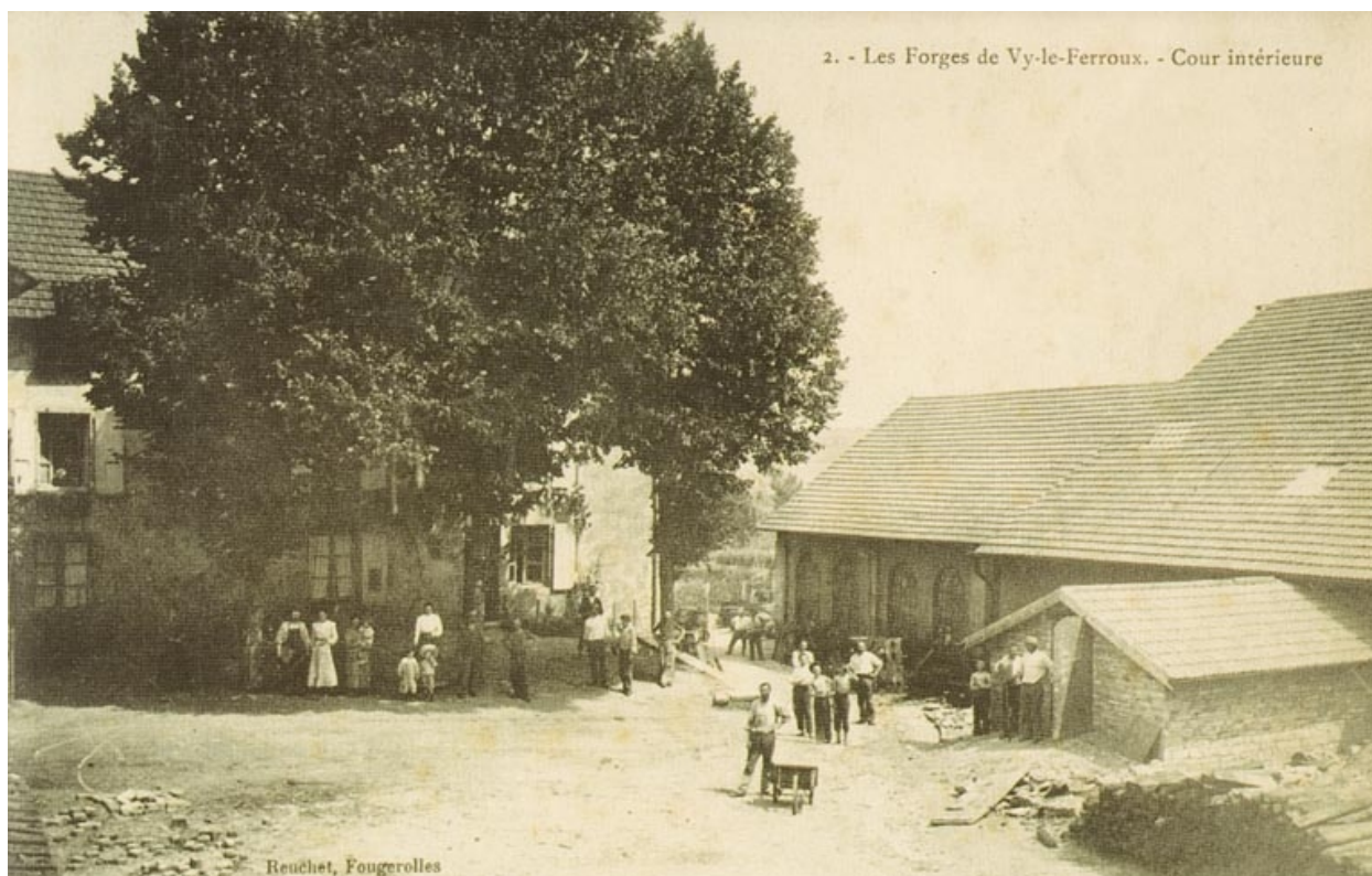
Les Forges de Vy-le-Ferroux. Cour intérieure.
