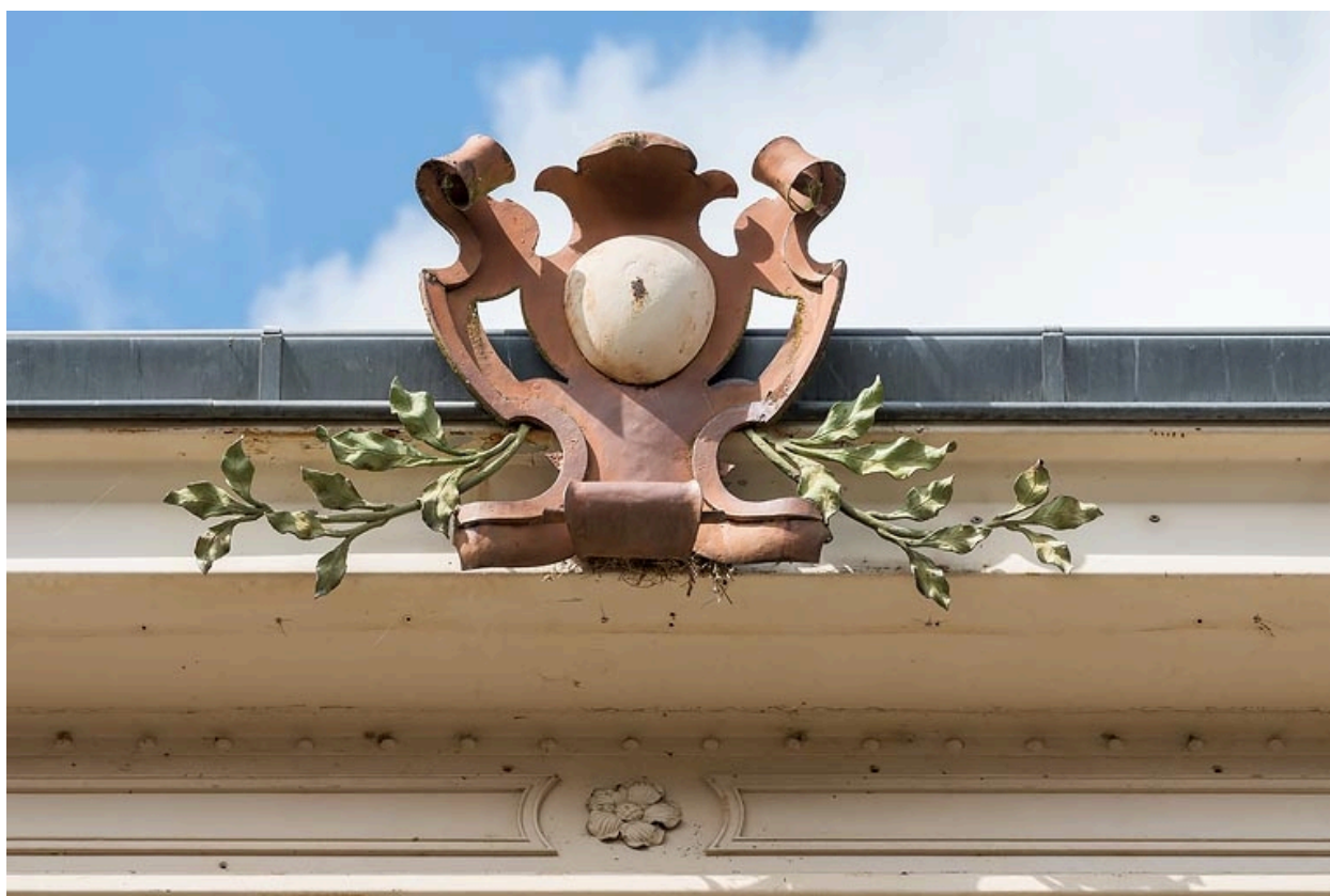
Aile ouest, salle à manger, détail.
