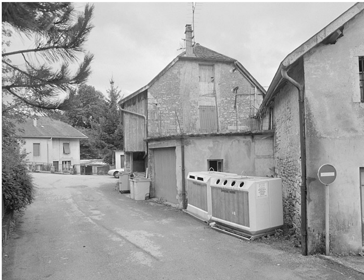
Face droite de l'ancienne fromagerie.
