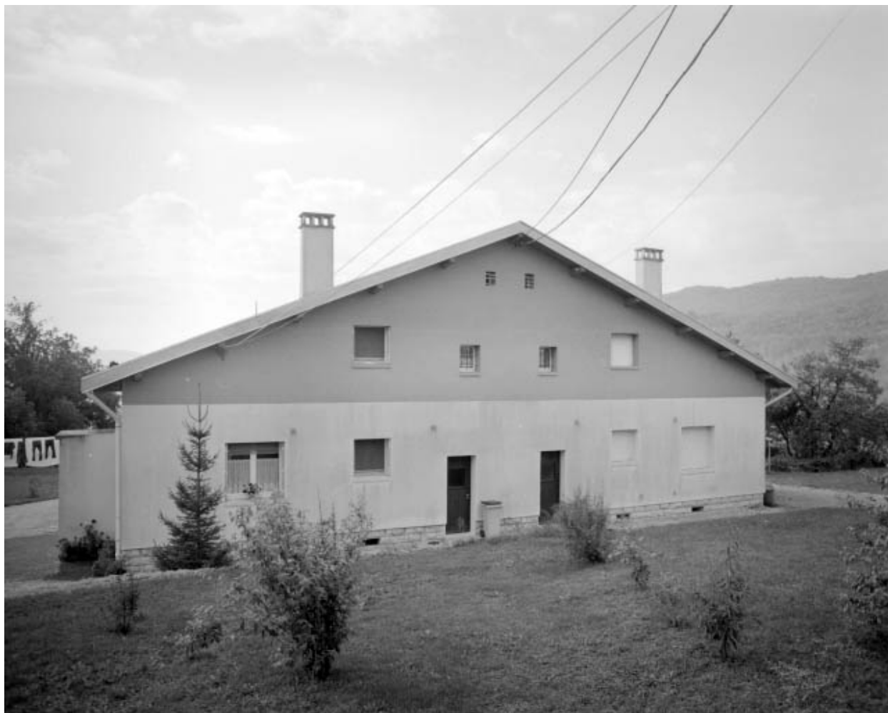
Maison d'agent de maîtrise : façade postérieure.
