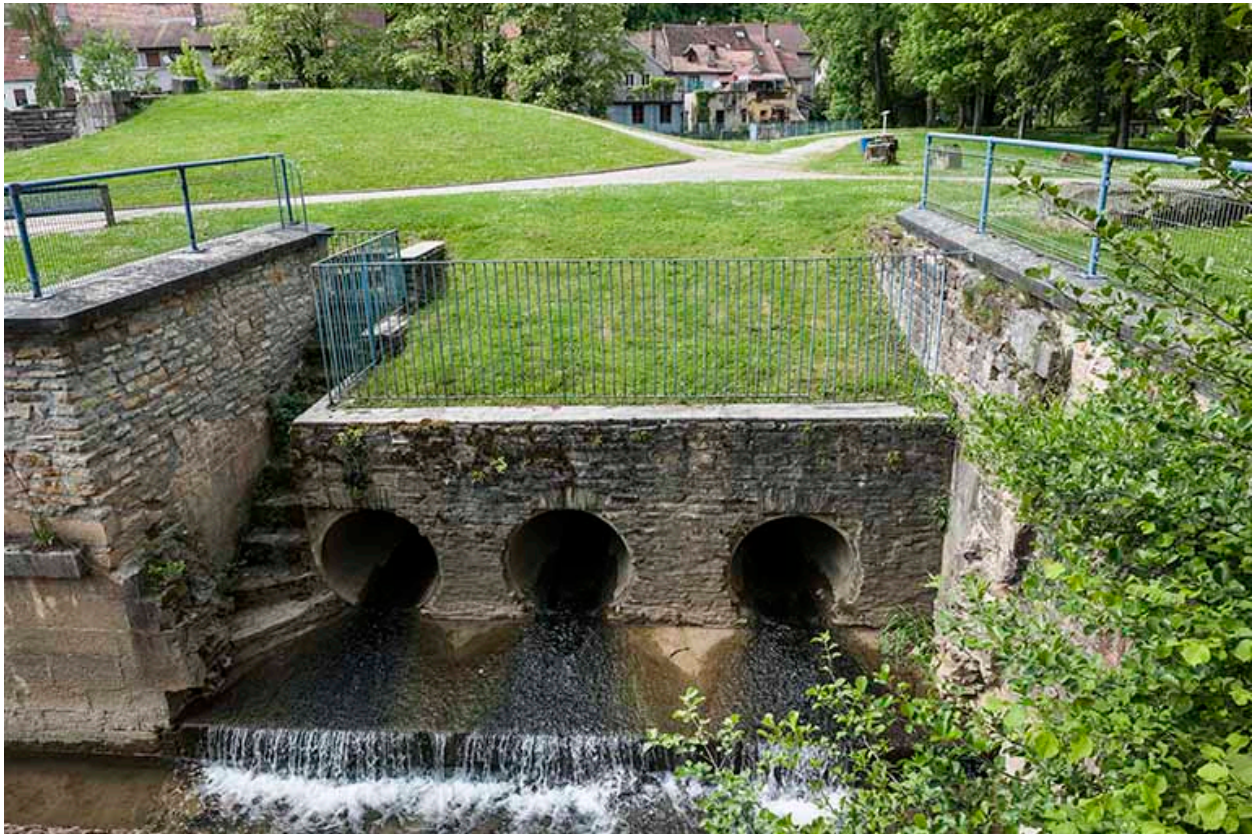
Vestiges des évacuations des turbines hydrauliques.
