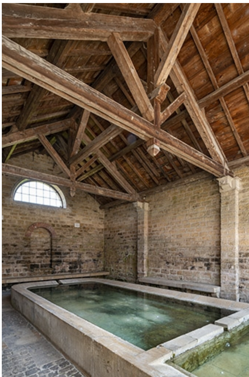
L'intérieur du lavoir, depuis l'entrée.
