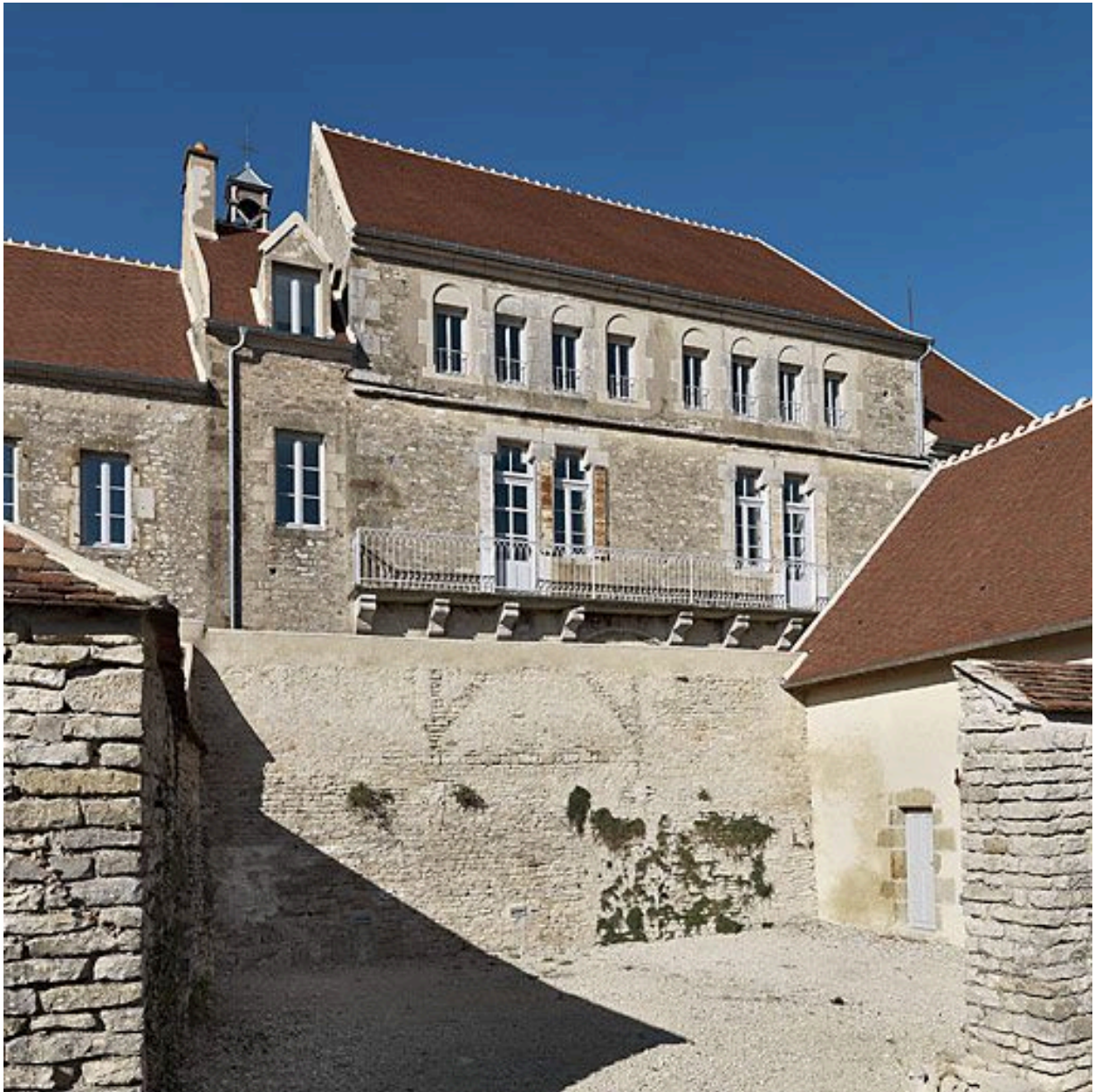
Façade postérieure du corps de bâtiment principal.
