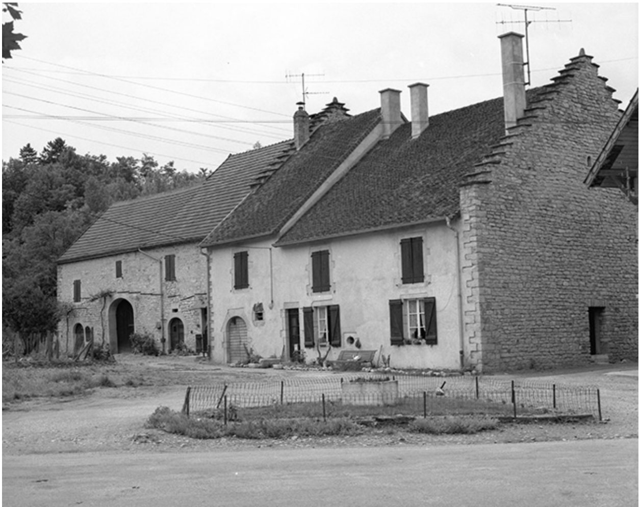
Fermes : façades antérieures vues de trois-quarts droit.
