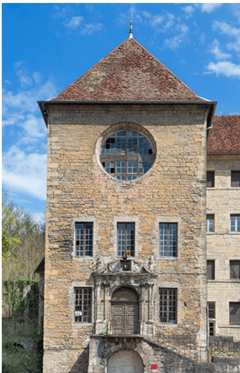
Façade ouest de la chapelle.
