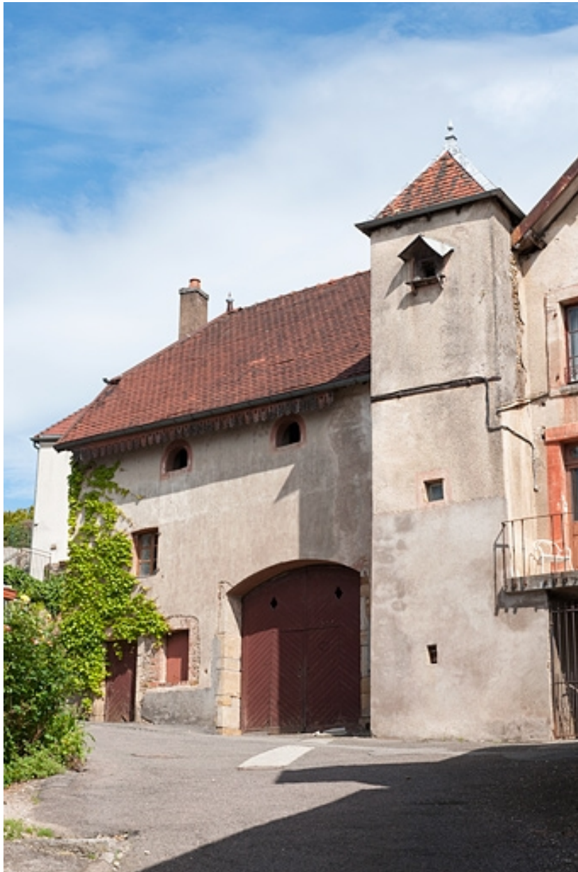
Façade antérieure : parties agricoles et tour d'escalier abritant le pigeonnier.
