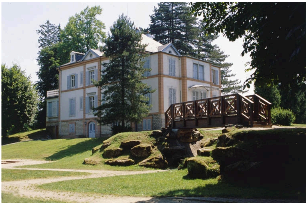
Le logement patronal depuis l'ouest.
