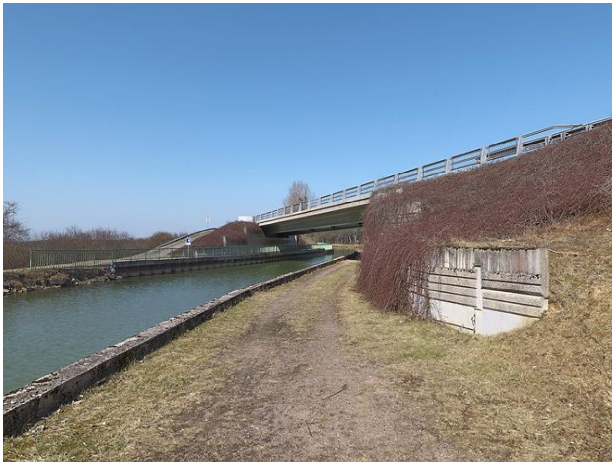
Vue d'ensemble du pont.
