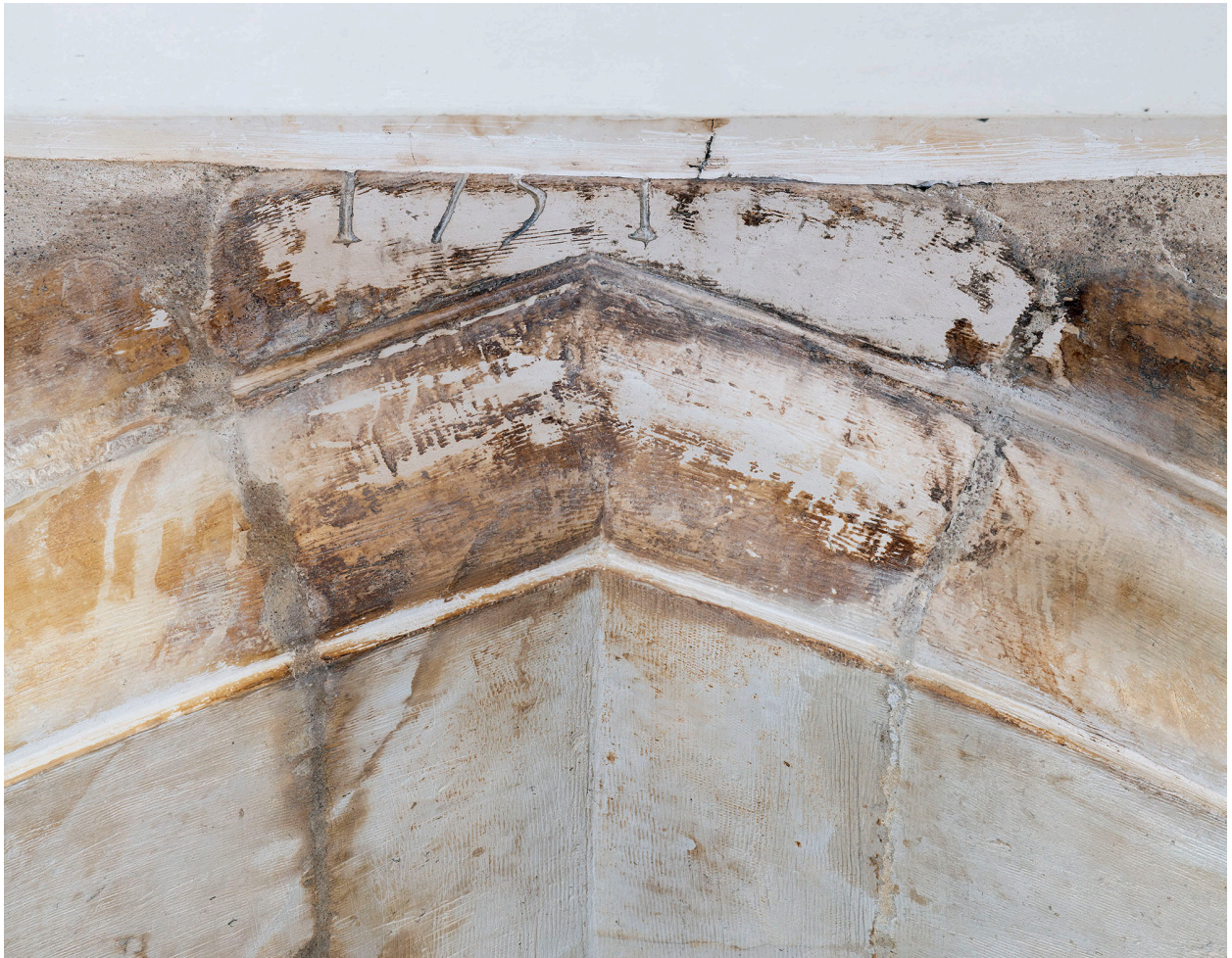
Arc brisé du transept nord : date (1751).
