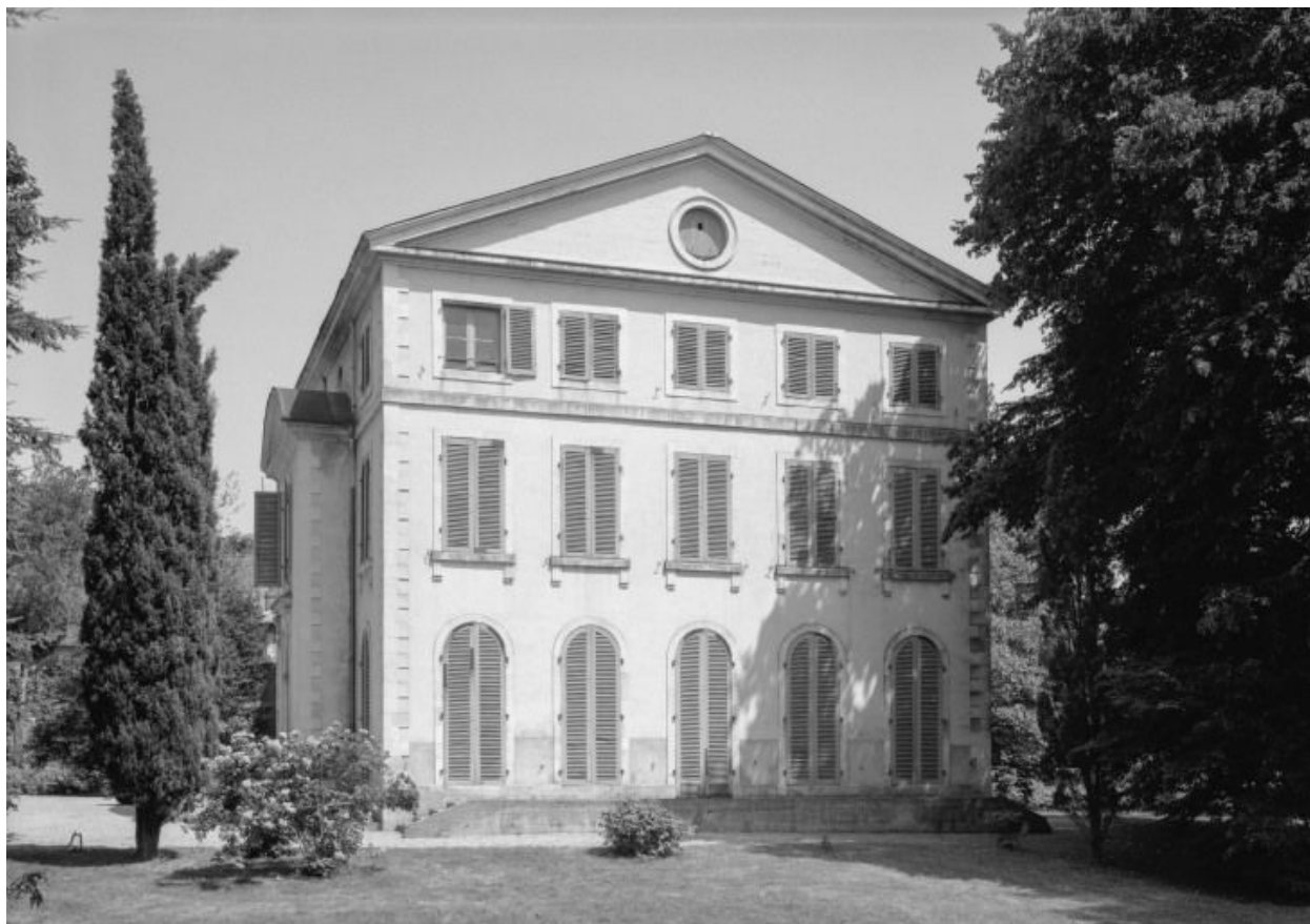
Pavillon ouest, élévation ouest.
