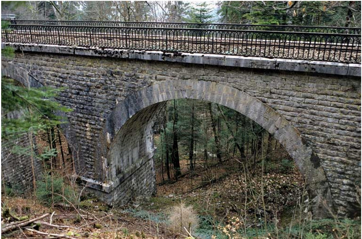
Viaduc : détail d'une travée, au sud (côté rocher).
