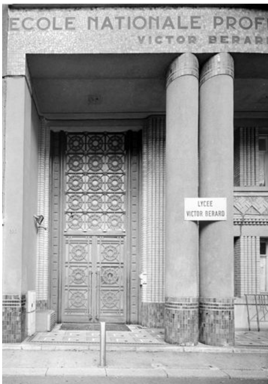
Bâtiment A : portail d'entrée.
