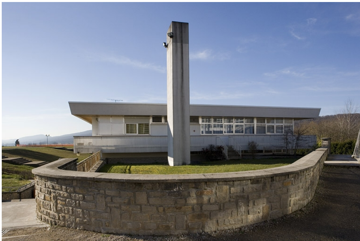
Angle du bâtiment d'internat.
