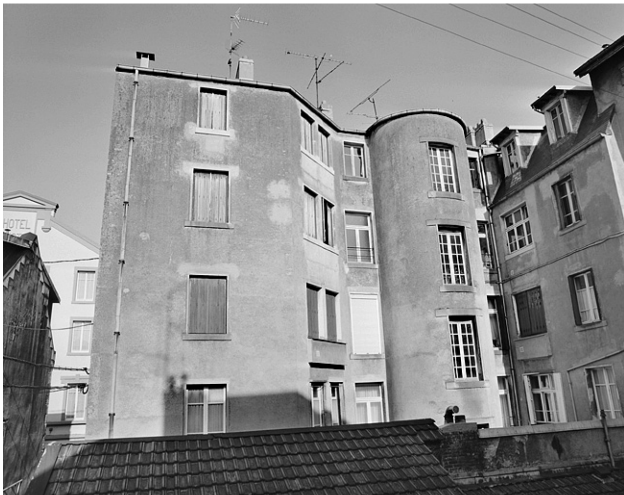
Façades sur cour.
