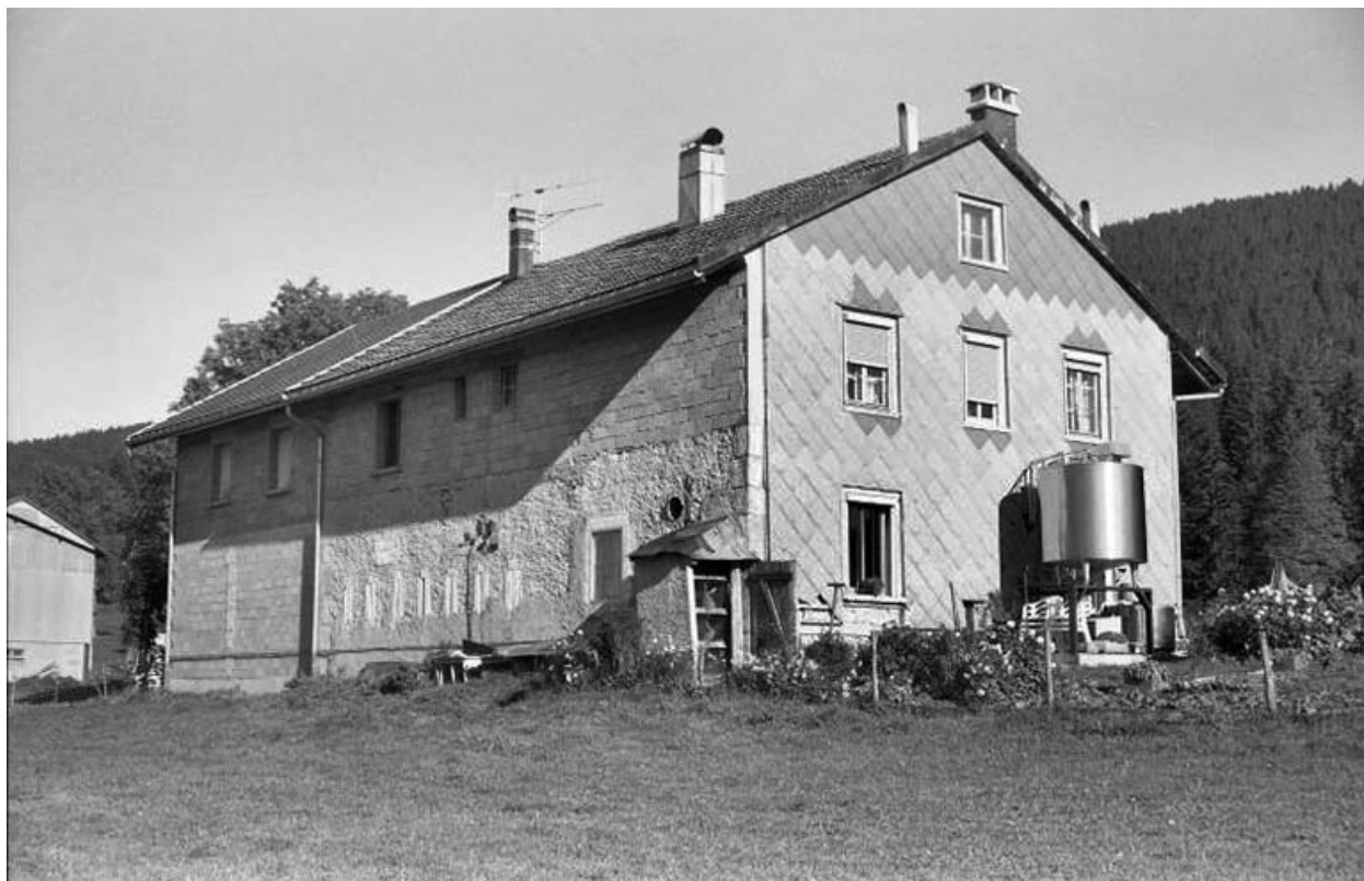
Façades postérieure et latérale gauche.
