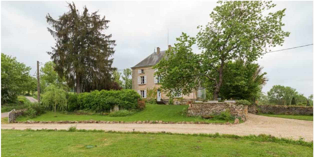
Maison d'habitation. Vue d'ensemble depuis le nord.
