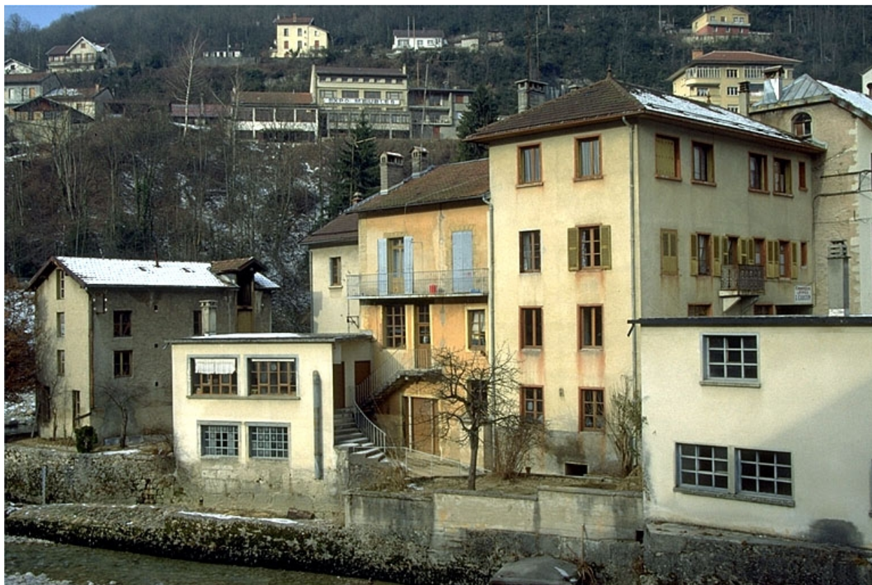
Bâtiments vus de l'est.
