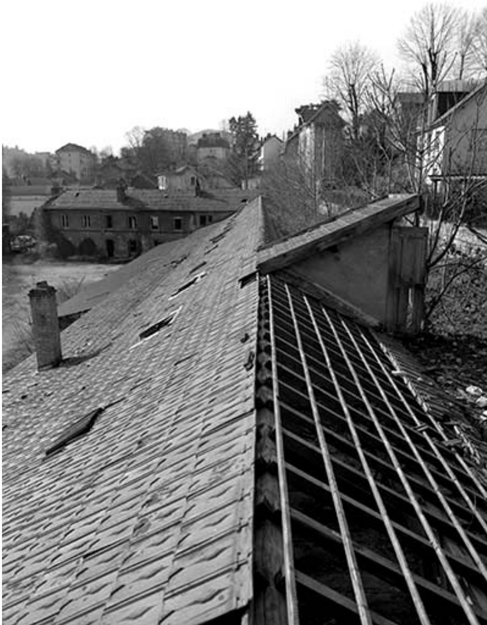
Toiture de la menuiserie.
