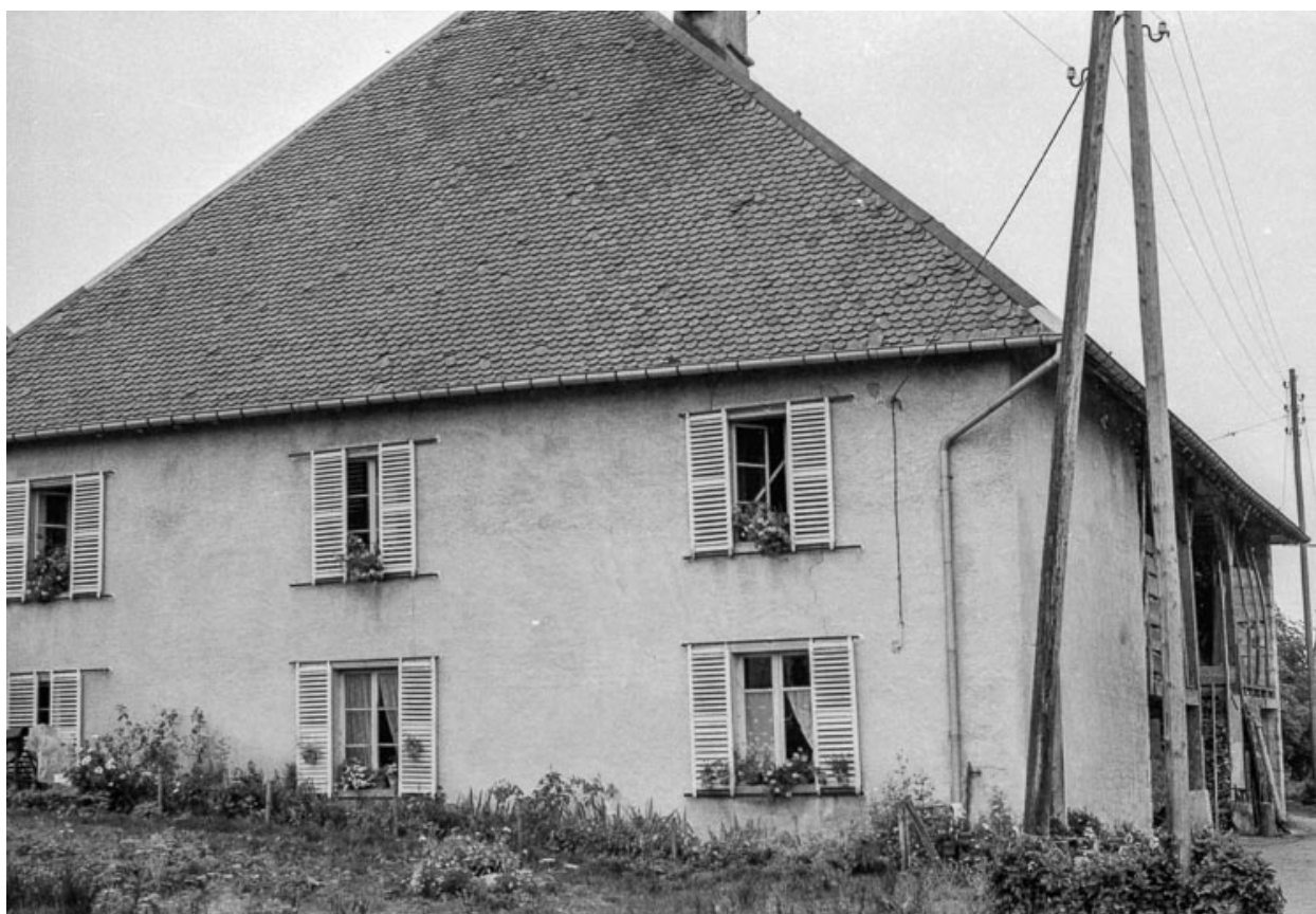
Ferme cadastrée 1939 B 192 : façade latérale gauche.
