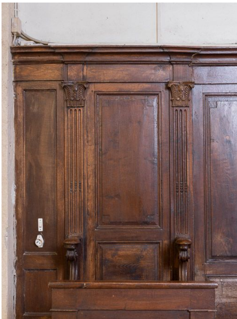
Détail des pilastres.
