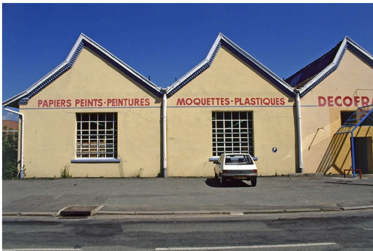
Pignons ouest de l'atelier de fabrication.
