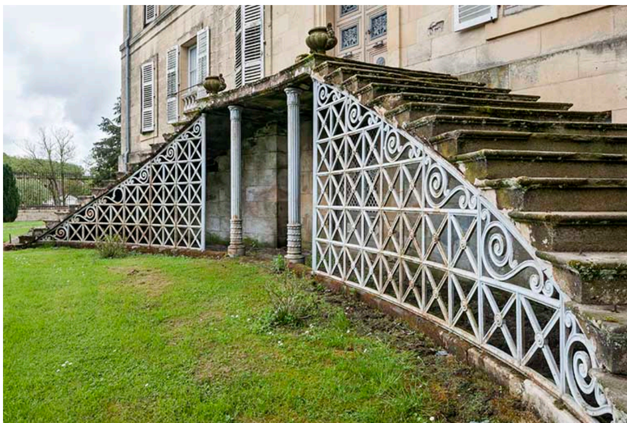
L'escalier double, façade nord.
