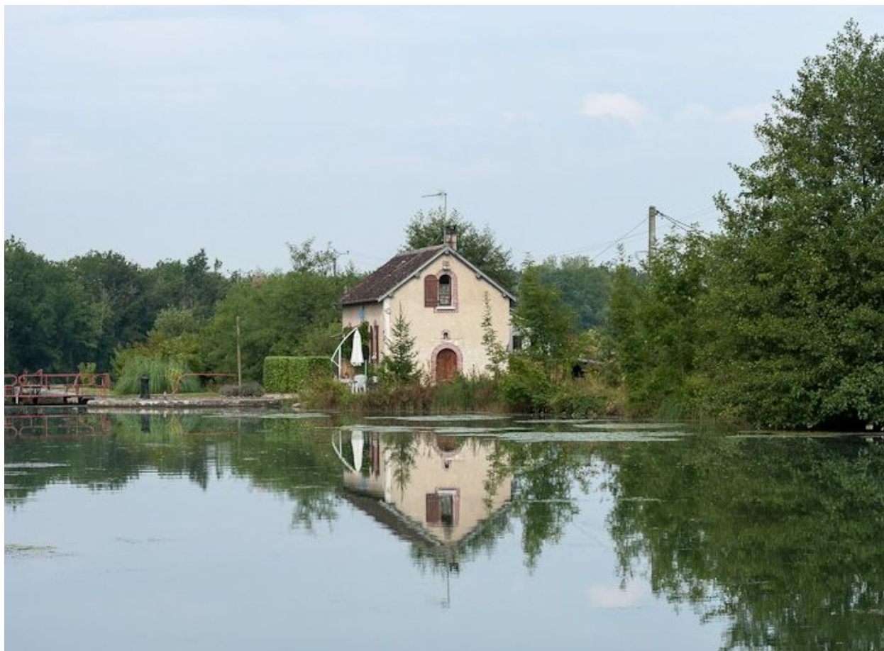
Maison éclusière dans son site.
