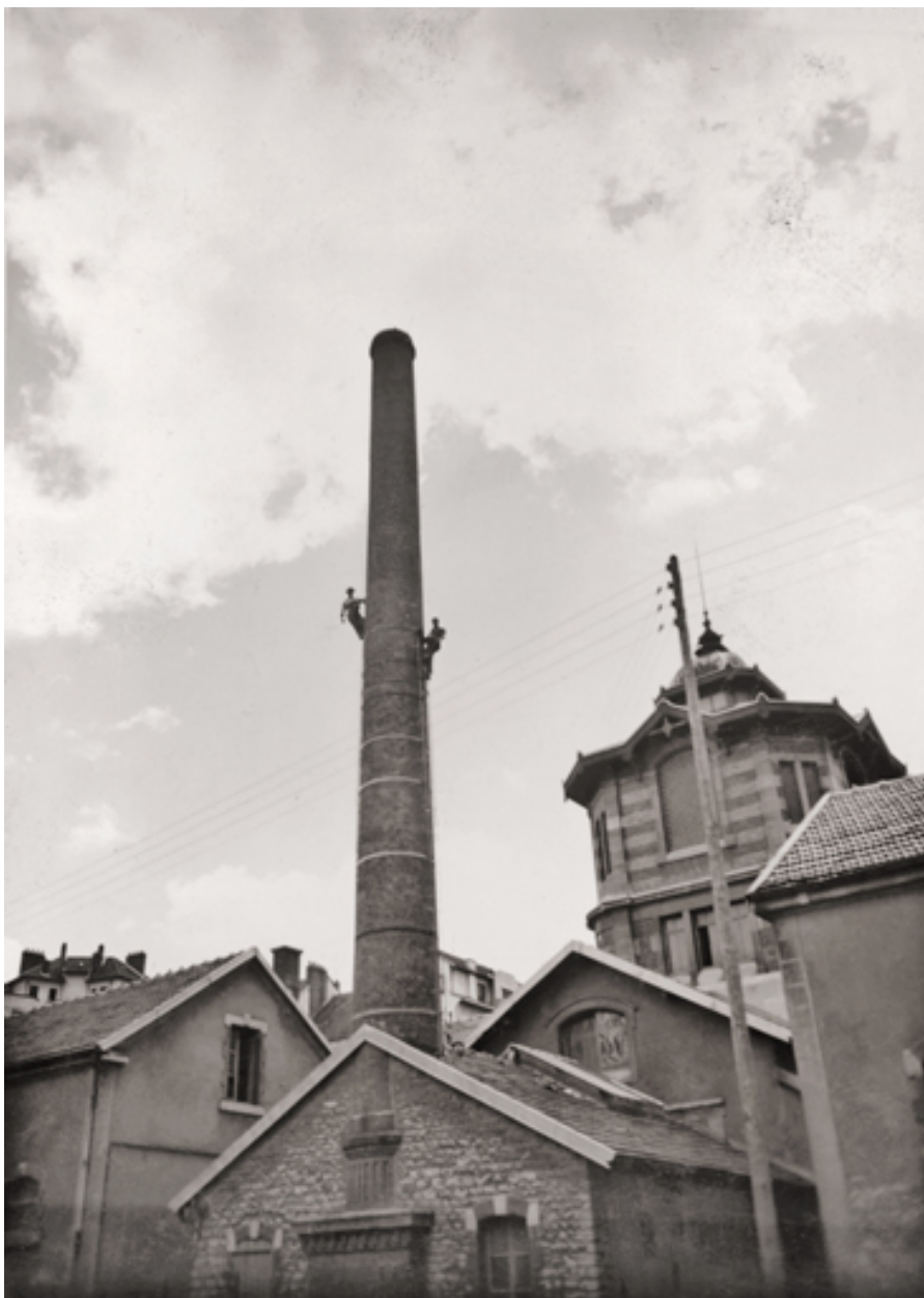
Cheminée de la chaufferie (vers 1950).
