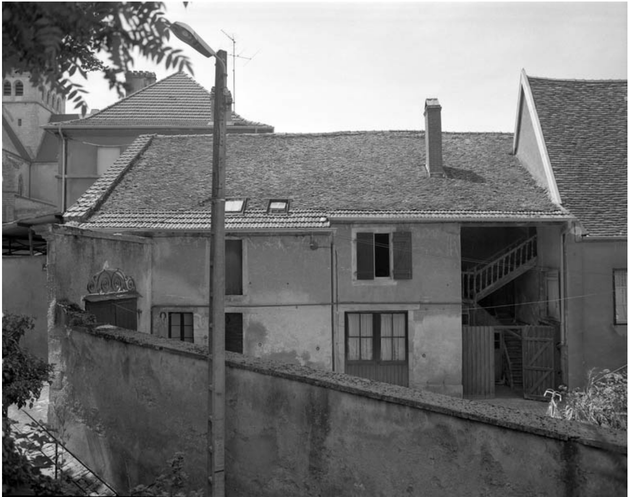
Façade antérieure du logement sur cour.
