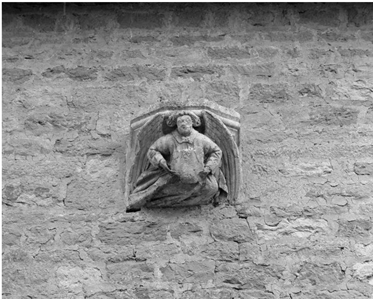
Façade antérieure : console gauche.
