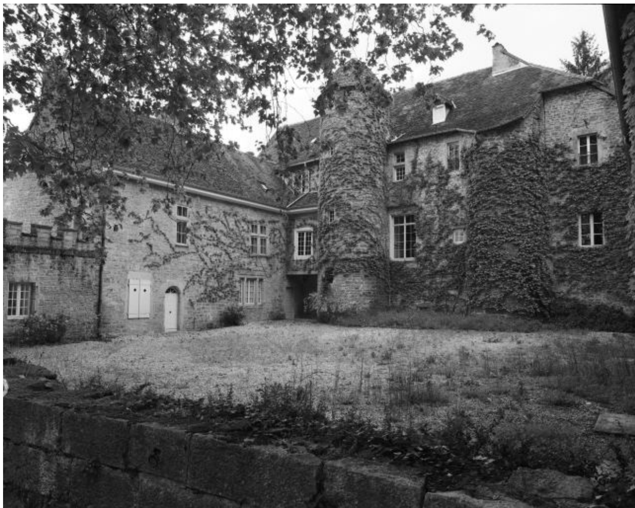
Façade sur cour et aile gauche.
