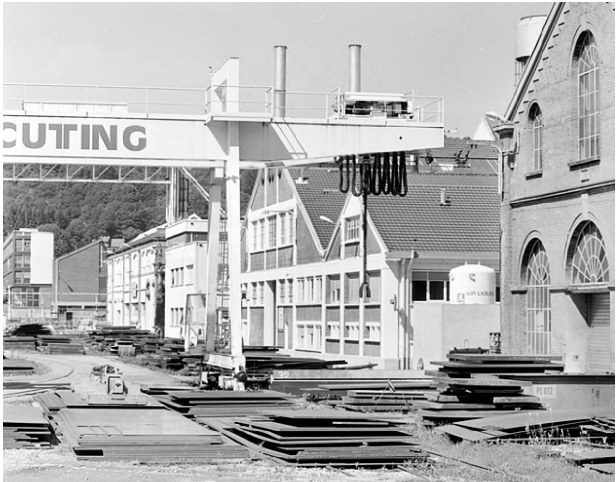
Alignement des pignons d'ateliers sur la rue 3.
