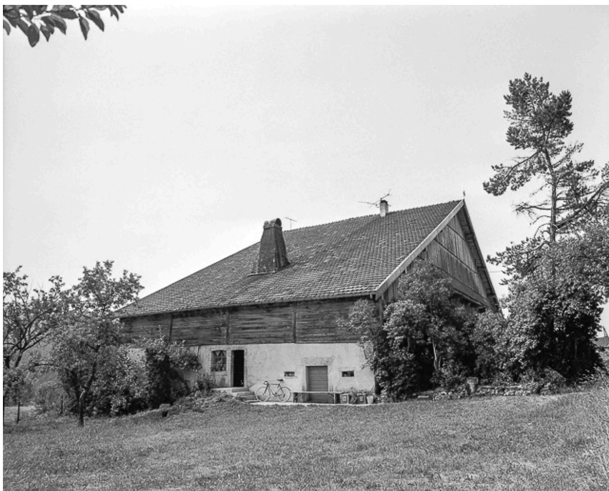
Ferme située au lieu-dit Colombière, cadastrée AB 82 : façade latérale droite.
