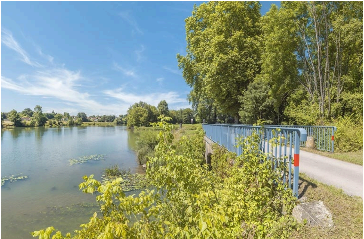
Vue d'ensemble du pont biais. A gauche, la Saône.
