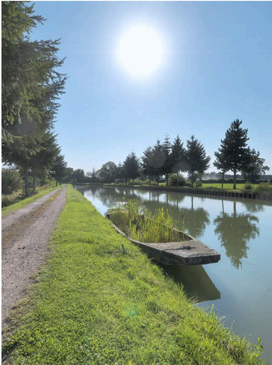
Brise-glace dans le bief 17. Alignement de sapins.
