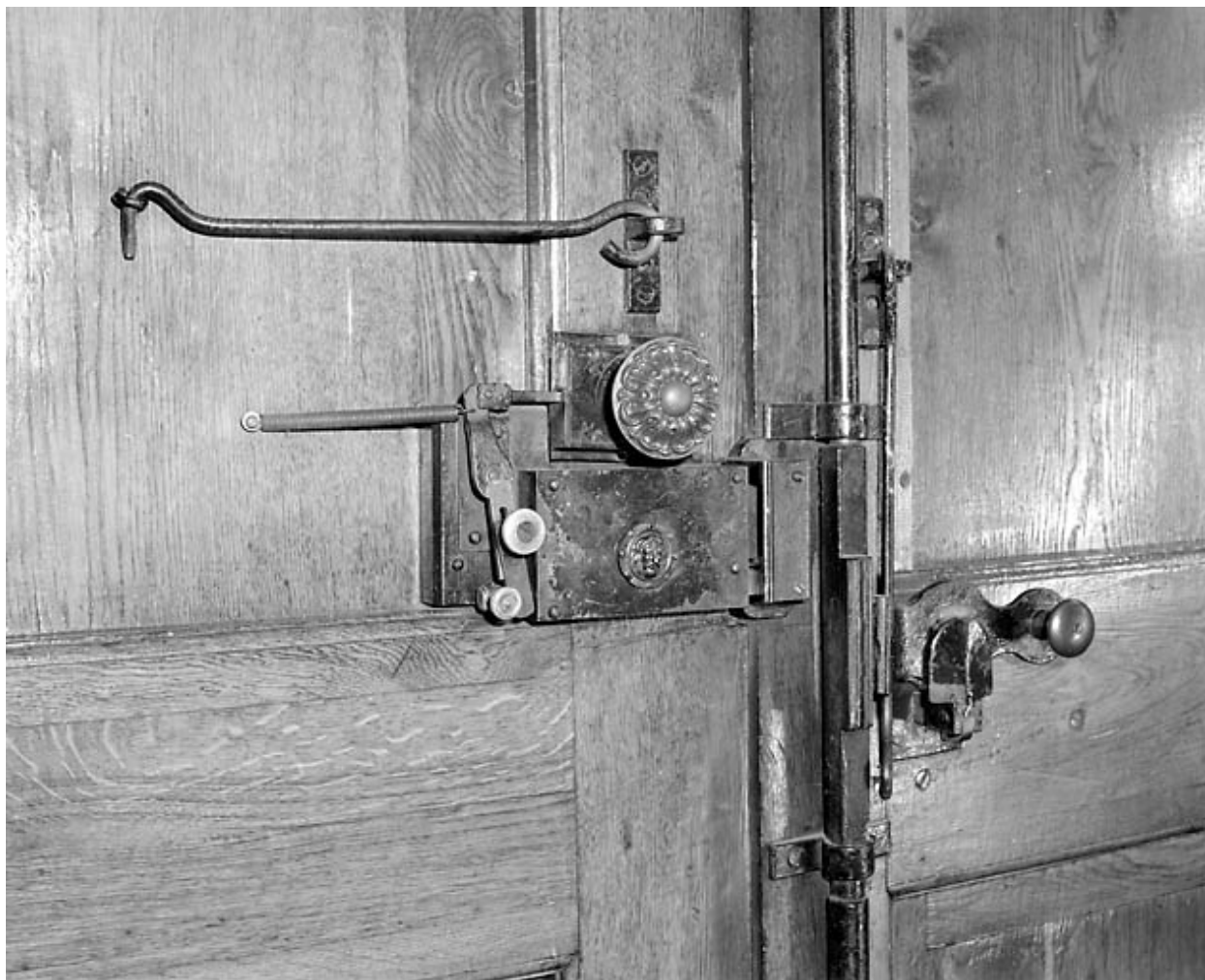
Porte principale : serrure et fermeture intérieure.
