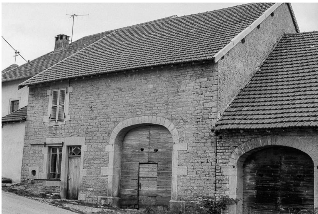
Ferme cadastrée B2 124 (droite) : façade antérieure.
