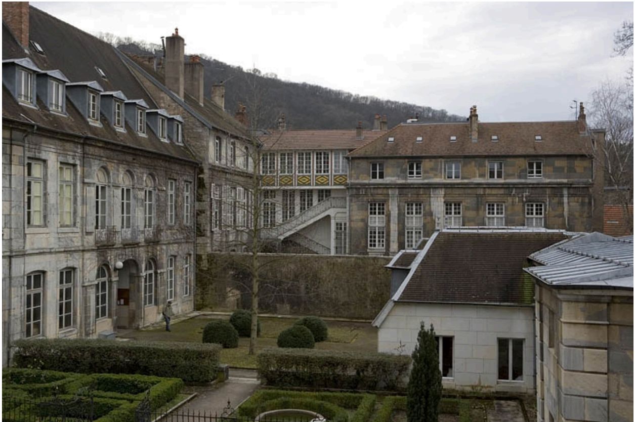
Vue d'ensemble de la façade sur cour, de trois quarts gauche.
