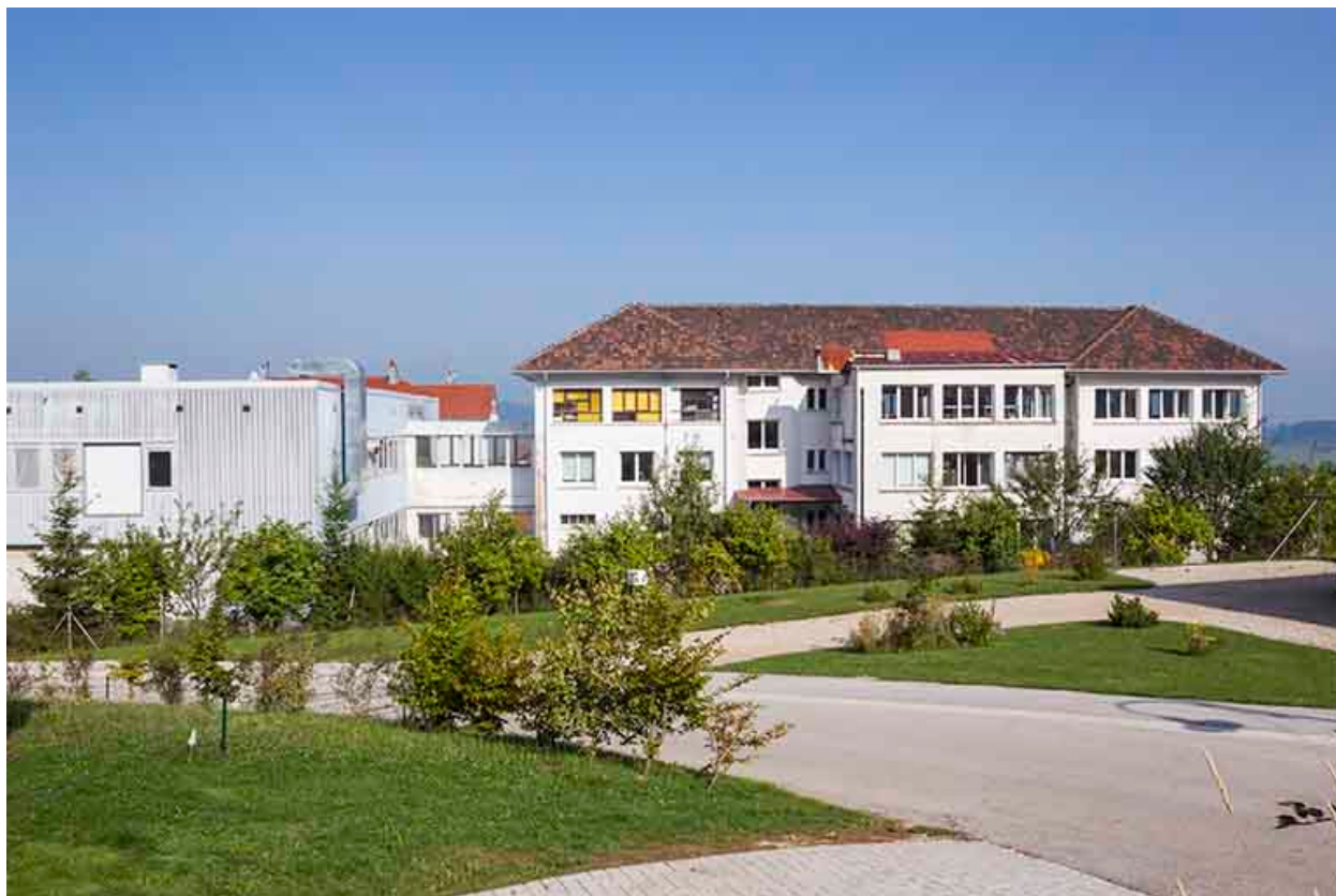
Ateliers de 1952 et 1970-1971 : façade postérieure.
