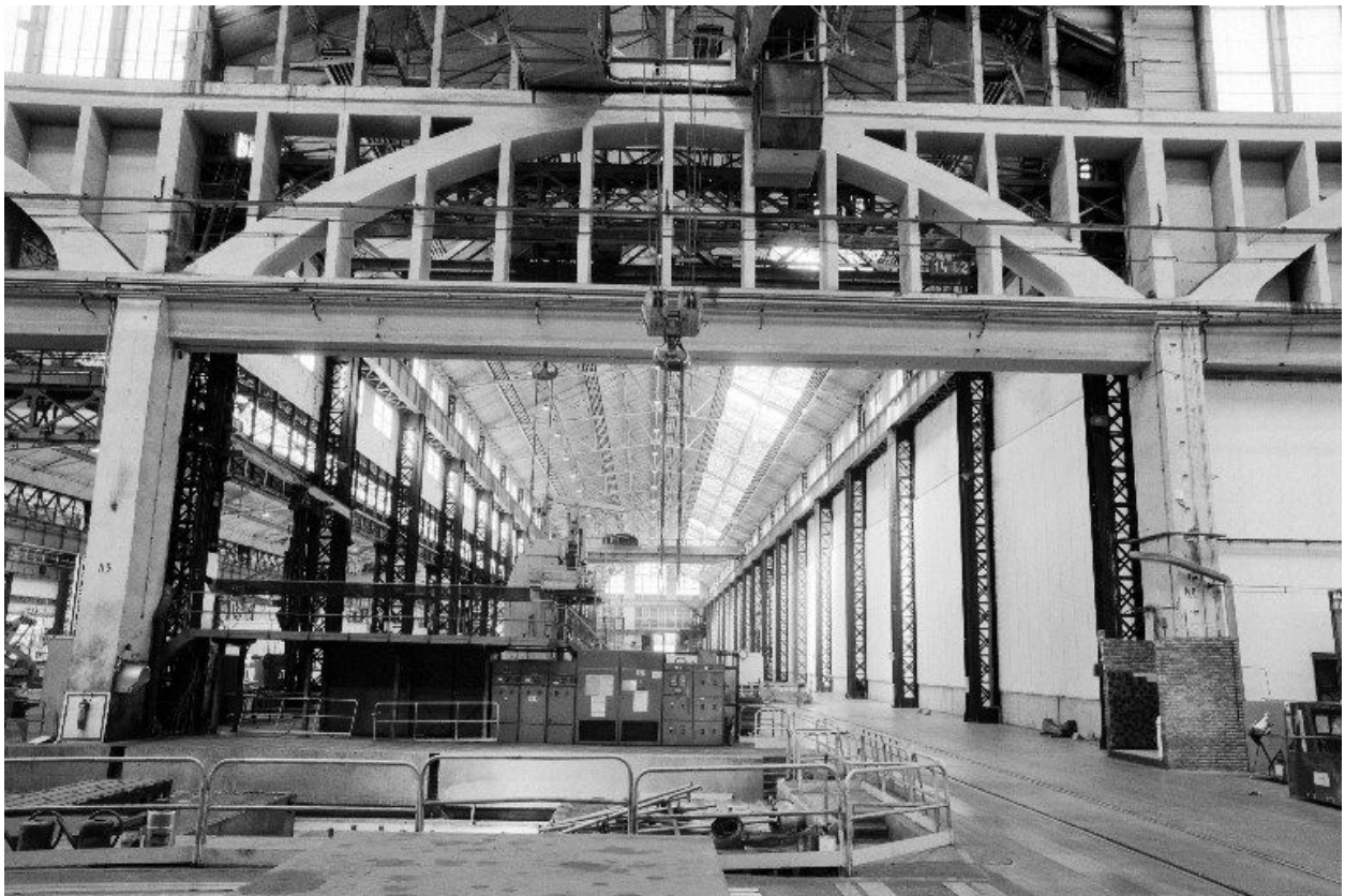
Les ateliers construits en 1912-1913 (travées orientales) vus depuis la halle de montage de 1919.
