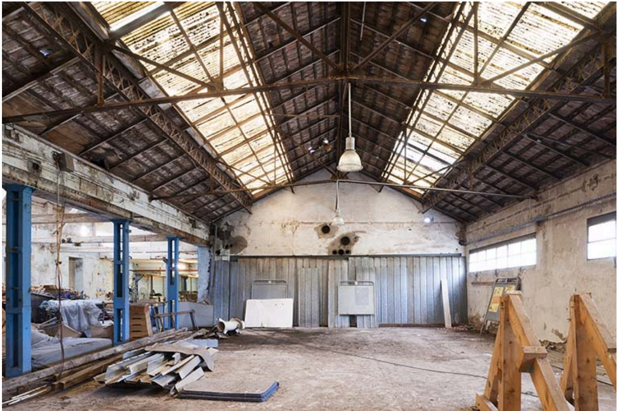
Atelier d'usinage. Travée est.
