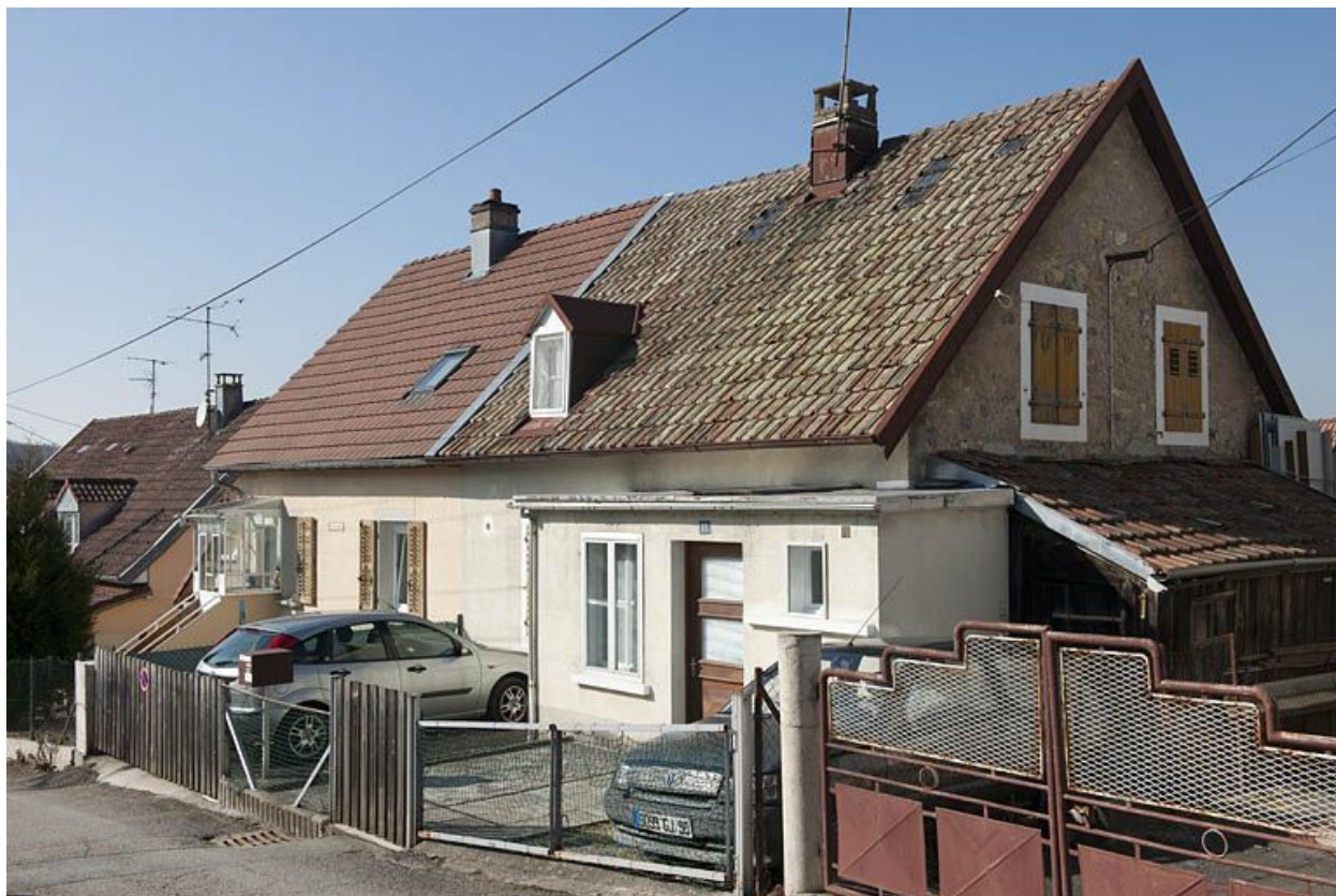
Maison jumelée rue d'Alsace.
