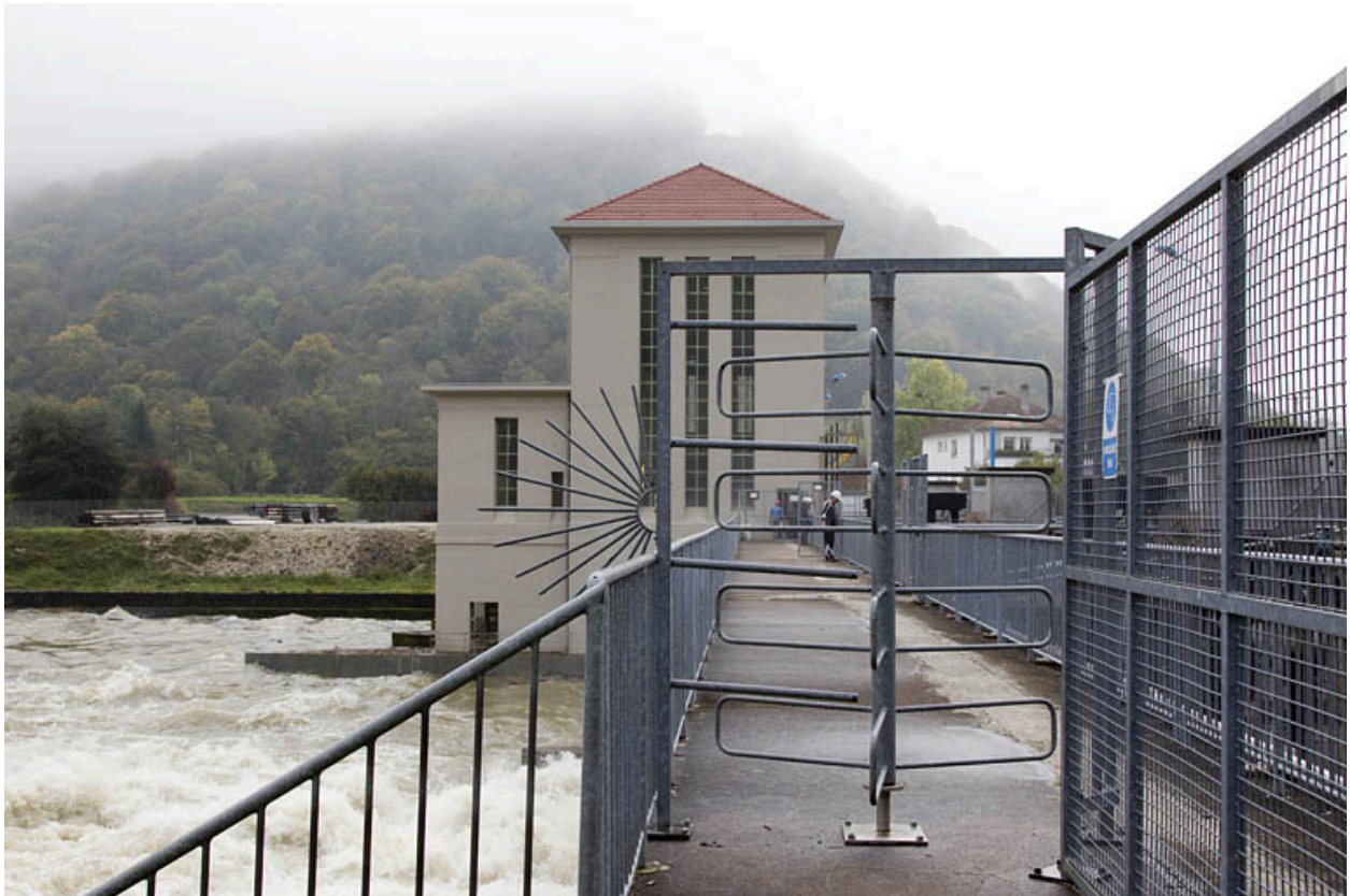
Vue de la centrale depuis l'extrémité ouest du barrage.
