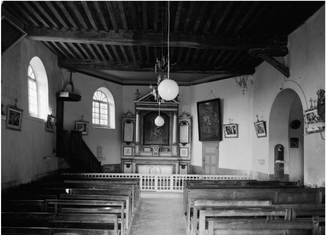
Vue d'ensemble prise de l'entrée (photo prise en 1978).
