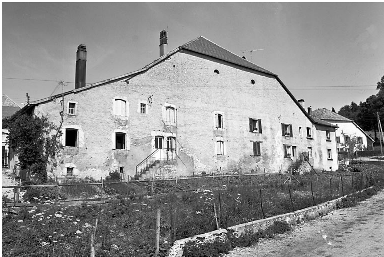
Ferme située route de La Planée à Oye-et-Pallet.
