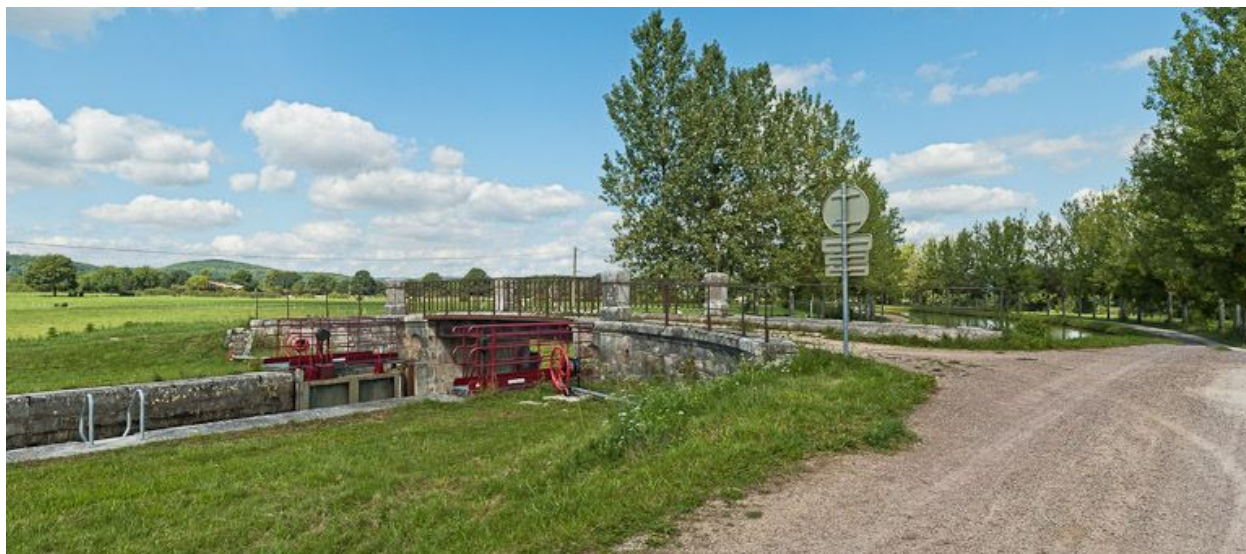
Vue du pont depuis l'amont.
