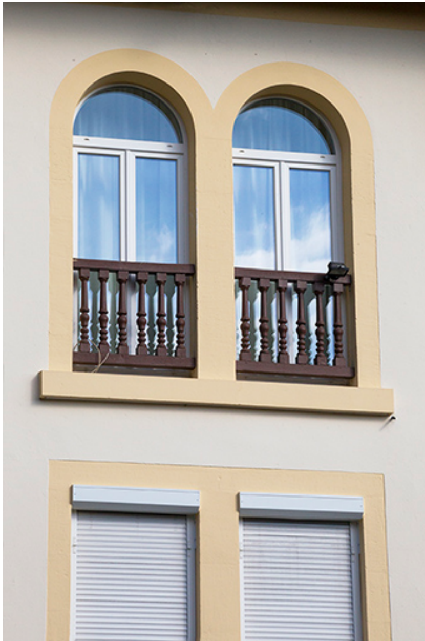
Logement patronal, façade méridionale : fenêtres.
