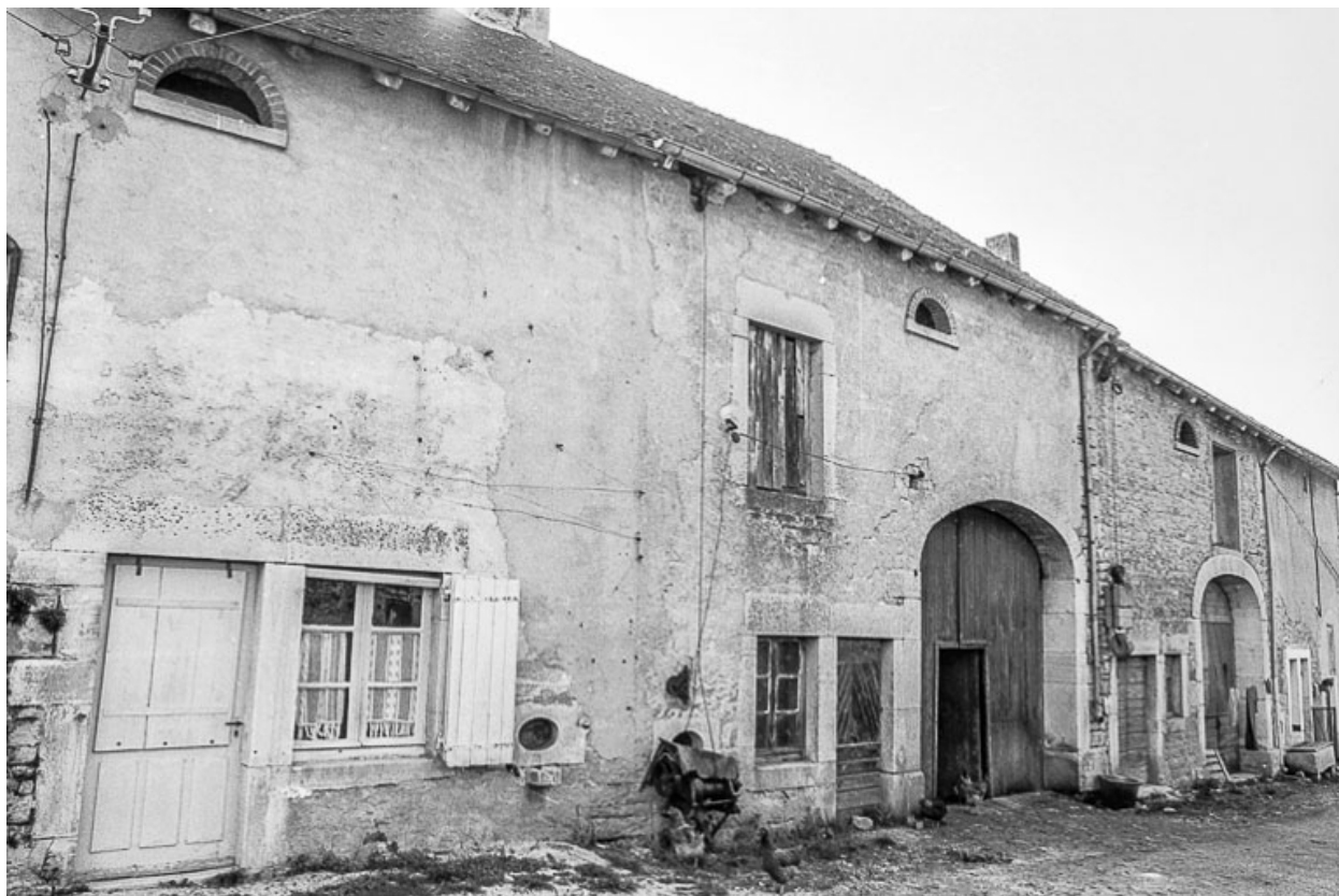
Ferme cadastrée D2 292 : façade antérieure.
