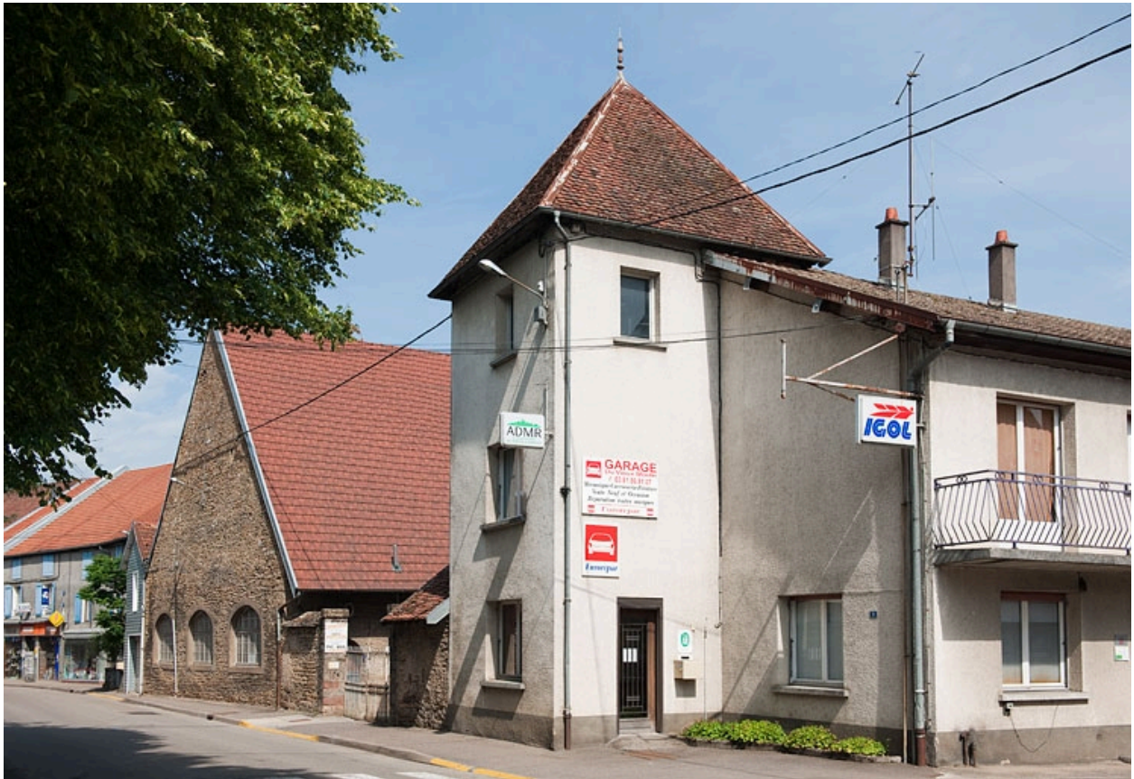
Maison au 9 rue du Vieux Moulin (2010 AK 289) et ferme au 7 (2010 AK 187).
