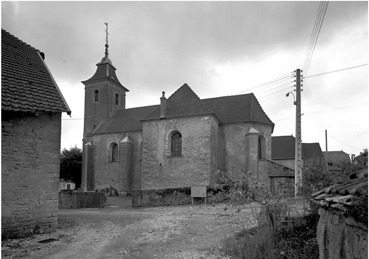
Façade latérale droite.
